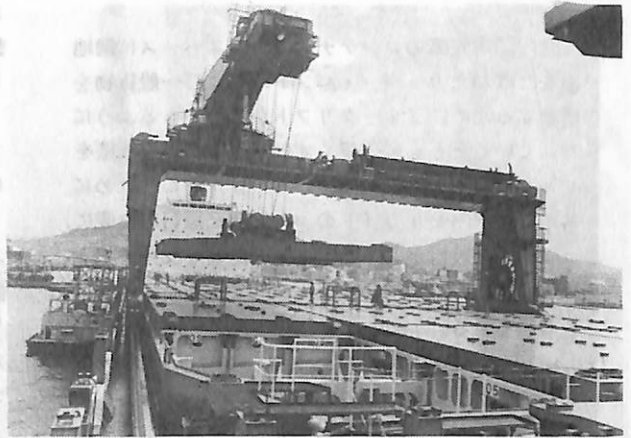
コンテナ・ガントリークレーン
