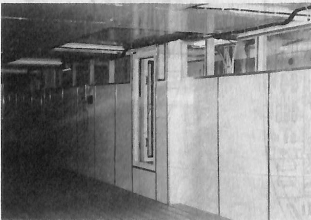
No. 3 冷凍貨物倉後端壁 (クーラー室前壁)
