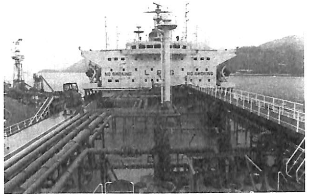
上甲板配管群
