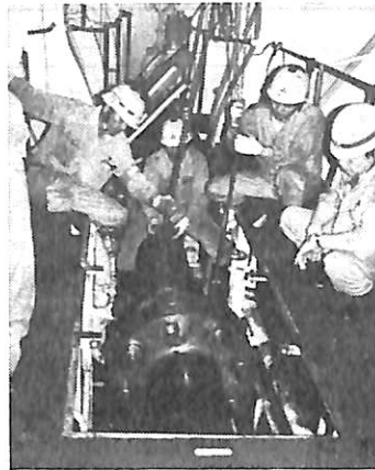
◀写真1 ピラーNSリーマボルトの抜き出し作業
