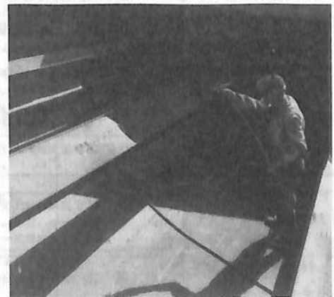
写真・8 エアレス・スプレー作業
