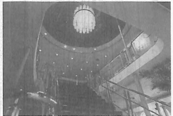
▲ ロビー階段部、天井
