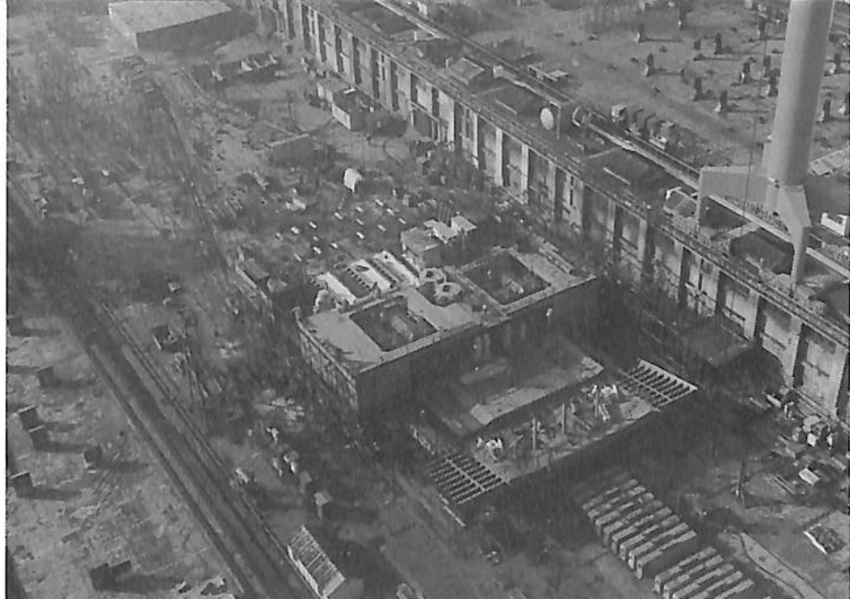
◀ 起工間もないボトムデッキ の状況
