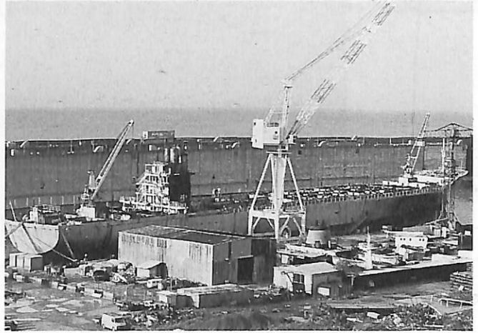
▲ コスタ社が買収、本格的な改装作業が着手された当時の姿。コンテナ固定の枠組みが分かる。撮影は、1988年7月31日である。
