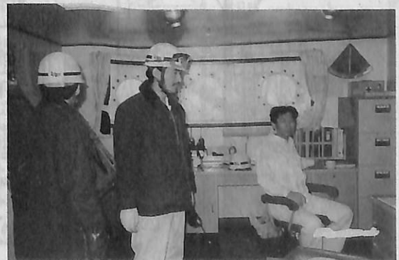
▲ 荷役制御室（ポンプ制御を行う）
