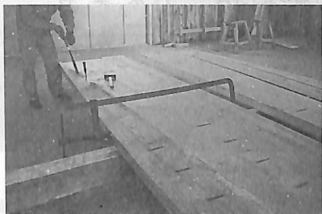
◀ すりあわせ作業 道具 (上部より) スリノコ ヤットコ カナヅチ キリン (イギリス)
