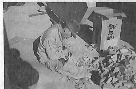
◀ 木ボルトの製作
