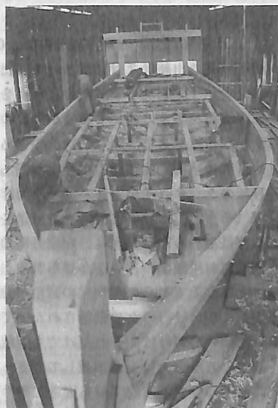
▲ 前部 桧肌縄打ち込み作業 後部 床の根太取付作業
