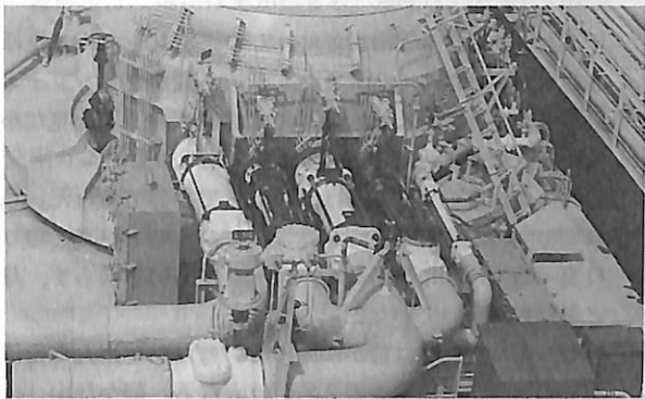
▲ 荷役中のパイプは白く霜が貼り付く。
