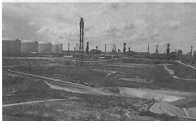
▲ 基地内プラント
