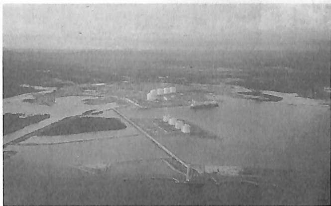
▲ バダック天然液化ガス基地（機内より）
