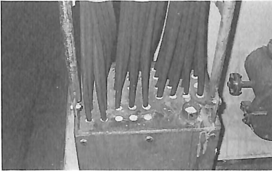
▲写真-2 CA装置のための船内電線貫通気密工事 則が追加された。
