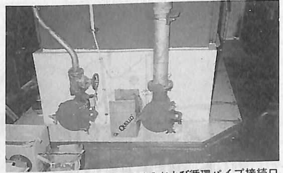
▲写真-3 CA装置N 2 ガス注入および循環パイプ接続口 年に竣工した大型鉱炭油兼用船“第3にっぽん丸”が初めてであり、主機関蒸気タービンのM0船としては国内で最初であった。また、冷蔵運搬船としては1973年に“いそかぜ丸”を国内初の船橋に機関および冷凍装置監視室を設置したM0船として竣工させている。なお、本船はマルシップであり、機関保守整備の面より上甲板に機関監視および冷凍監視室を設置した。主機関の操縦は
