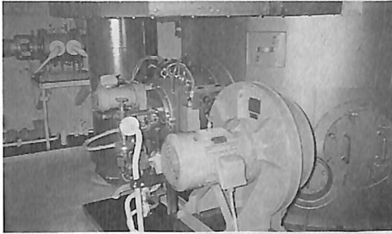
▲写真-7 補助ボイラ，ロータリーバーナー 発電機排ガス側……… 80 kg/h × 2
