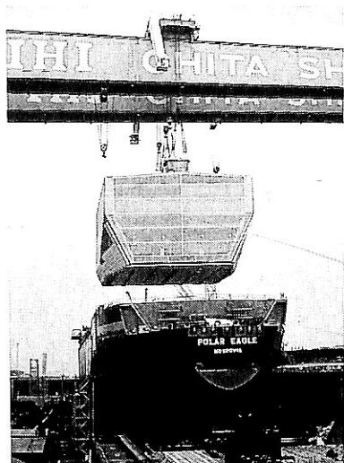
SPB方式LNGタンクの技術の独創性、革新性の評価をされた“POLAR EAGLE”
