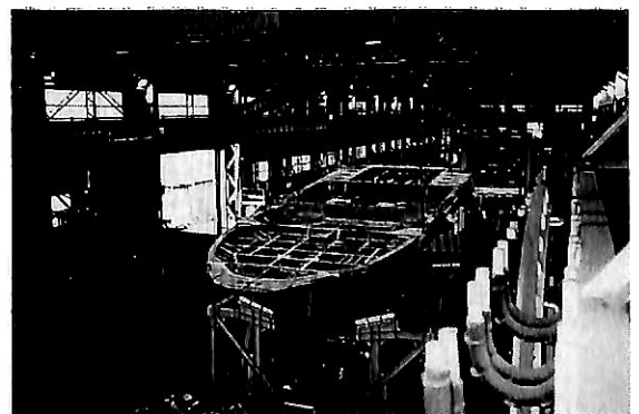
▲ 図10 建造中の「疾風」の上部船体
