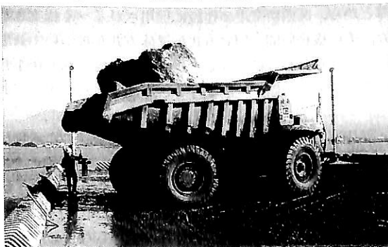
▲ 図-69 大型ダンプカーが大きな岩石を投入直前(作業員の大きさからダンプカーの大きさが分かる)
