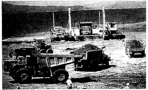
▲ 図-67 続々とモービルジェティーに向うダンプカー
