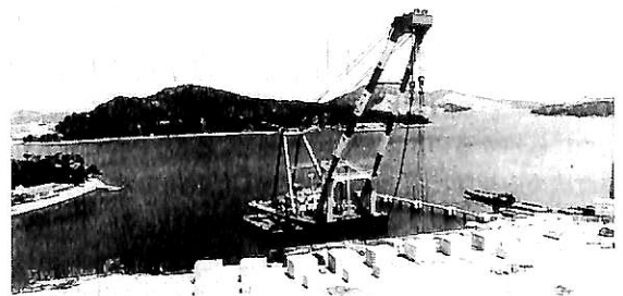
▲ 図-83 シンカー製作ヤード (700t吊起重機船が待機している)
