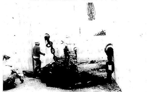
▲ 図-84 巨大なコンクリートシンカー(300t)
