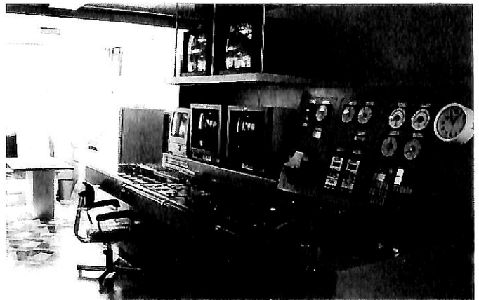
▲ 船橋主機操縦台
