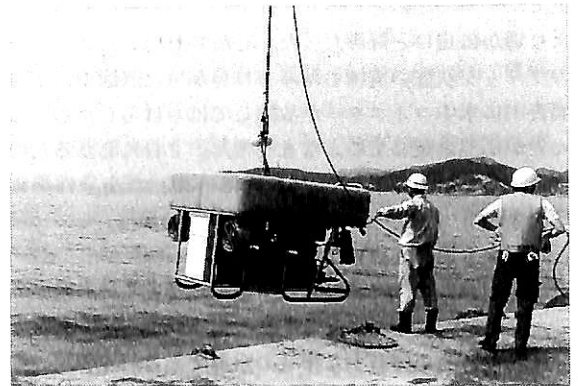
▲ 図15-11 海底ケーブル調査でMURS-300の入水作業
