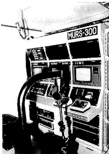
▲ 図15-3 総合操作盤
