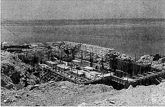
▲ 図20-8 ポンプ室の基礎工事
