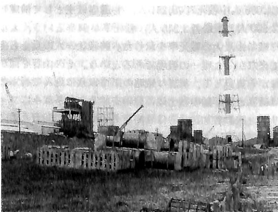
▲ 図20-10 現地に集積されたFRPパイプ、 背景は建設中のプラント工場
