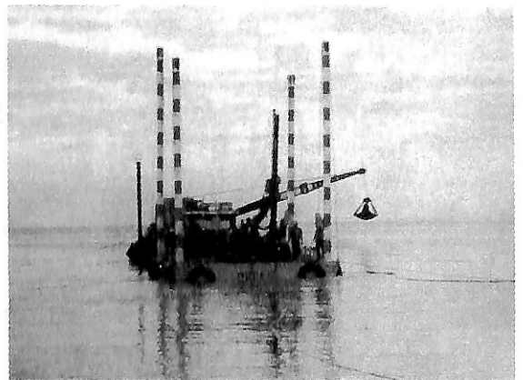
▲ 図20-7 海底管のトレンチ掘削工事中のミニSEP
