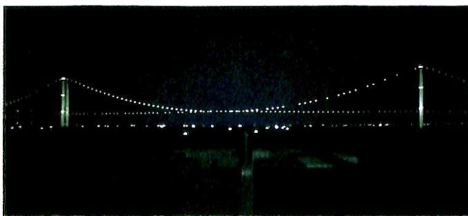
▲ 第 14・13 図 航路標識の配置と橋梁灯質の調査例
