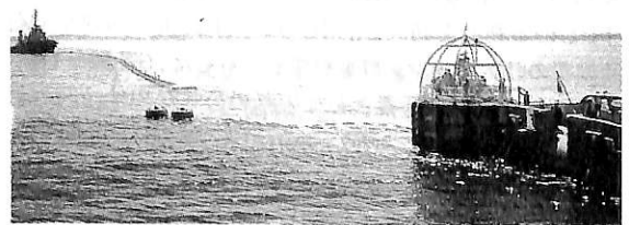
▲ 図 22-15 浮上ホースと係留索が取り付けられたSALMブイ
