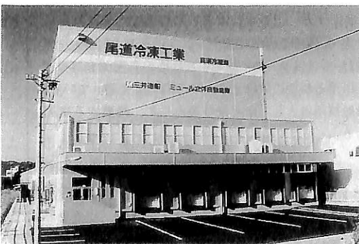
▲ 完成したミュール立体自動倉庫
