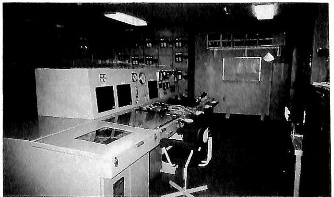
▲ エンジン・コントロール室
