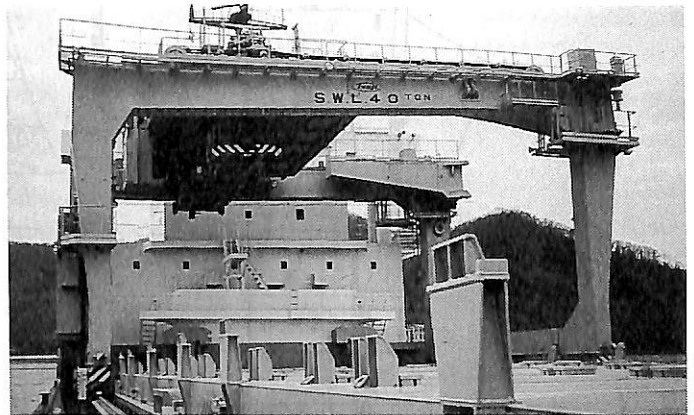
▲ 40トン門型走行式ガントリークレーン
