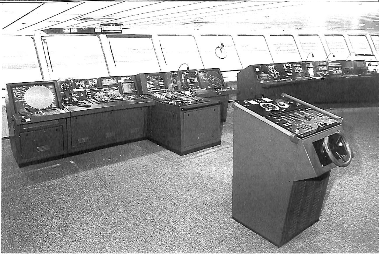
▲ Wheelhouse (コンソールは全てダークブルーで統一している)
