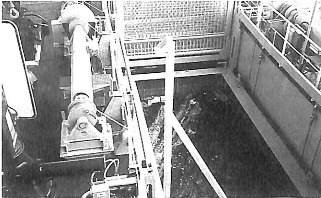
▲ ゴミ・木材の流入状態
