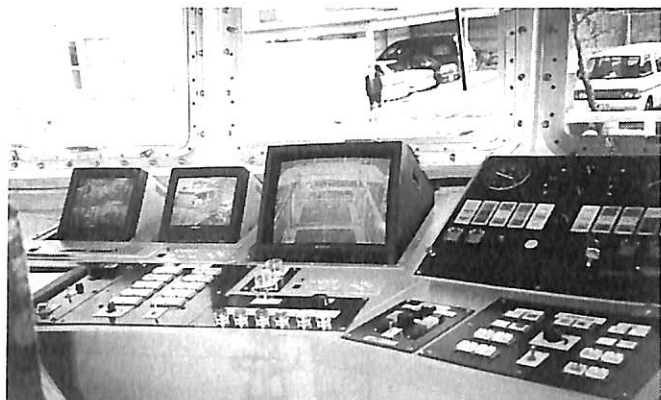
▲ 操舵室コンソール監視カメラ (左舷)
