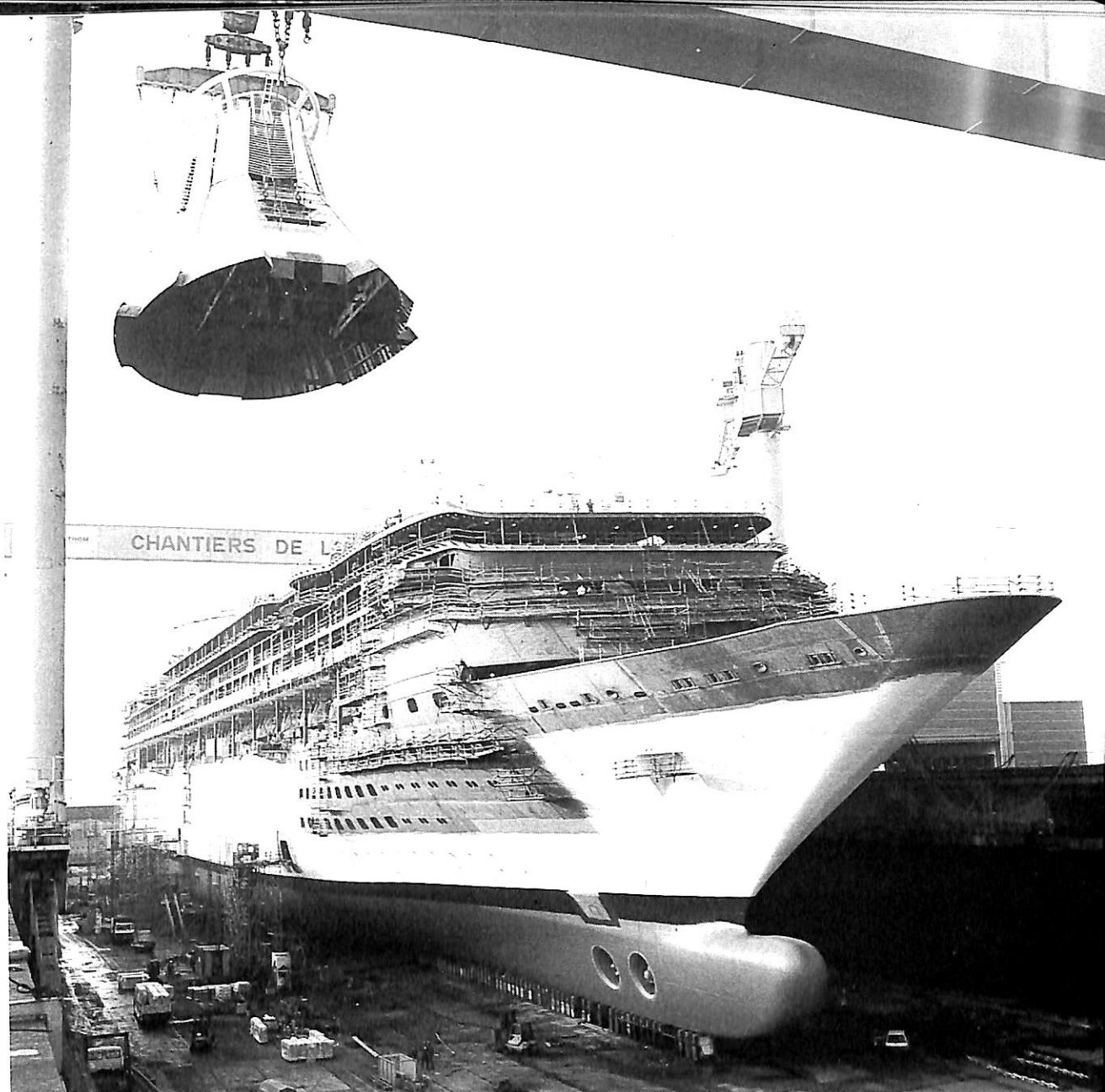
▲ 1997年8月24日の状況 船体組み立てはほぼ終わり、ファンネルの据え付けがまじか、船底塗装も完了している
