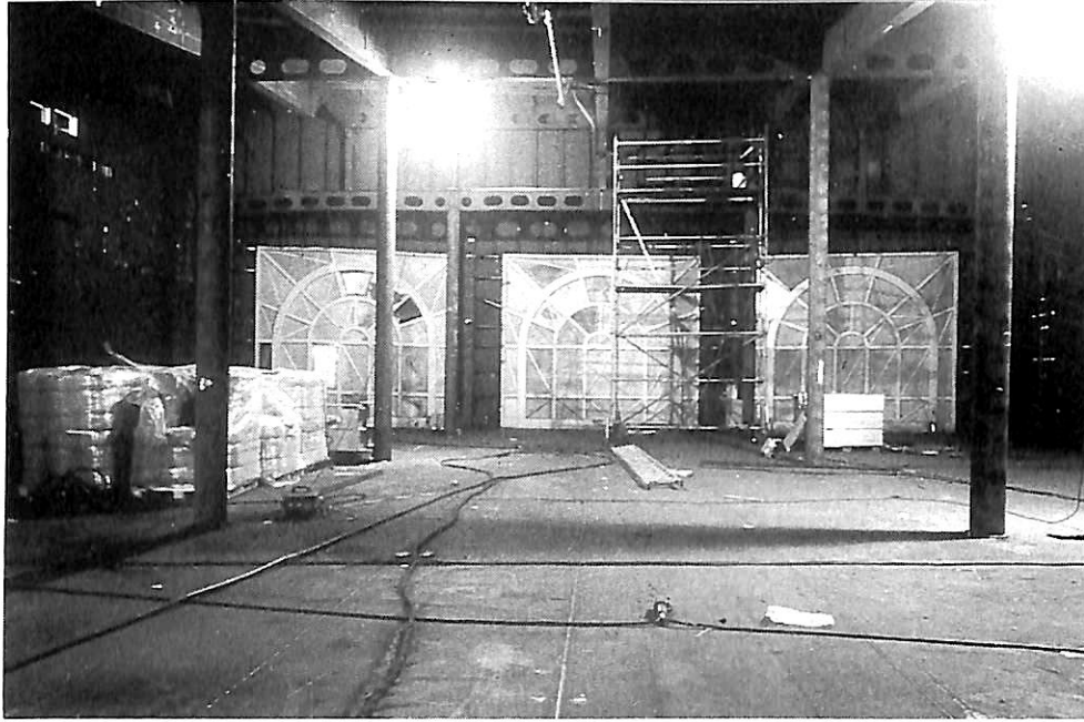
▲ Window's Restaurant 内装作業開始直前の状況
