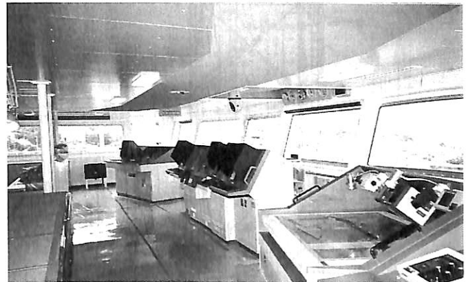
▲ コックピット型船橋操舵室
