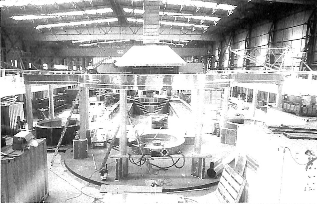
▲ Tivoli Pool Area 内装作業開始直前の状況
