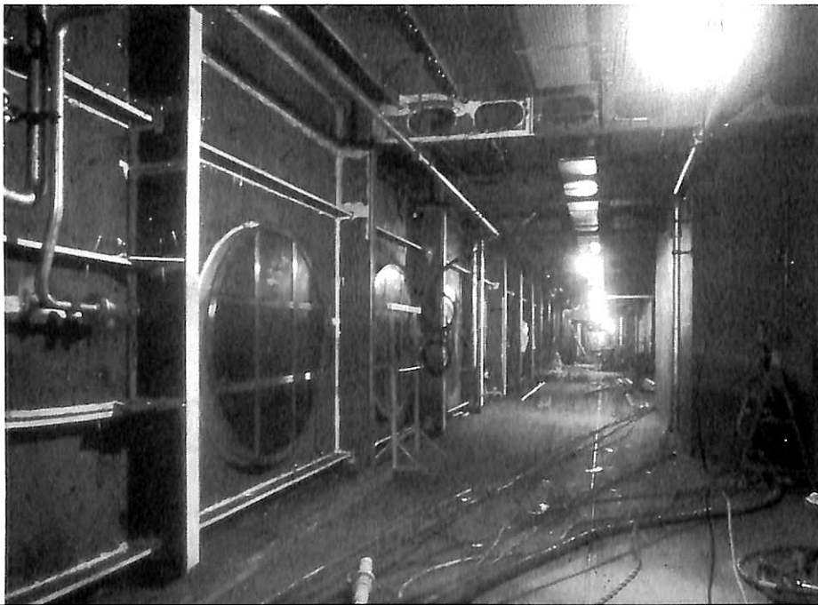
▲ Blue Lagoon 内装作業開始直前の状況
