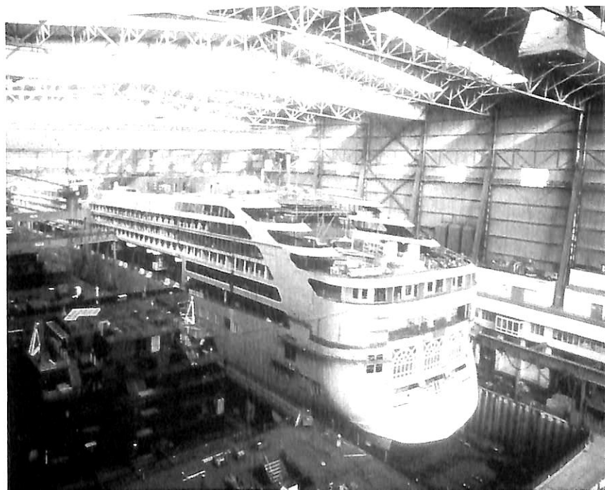
Back View ▶ 浮上直前の ドライドック内の 状況
