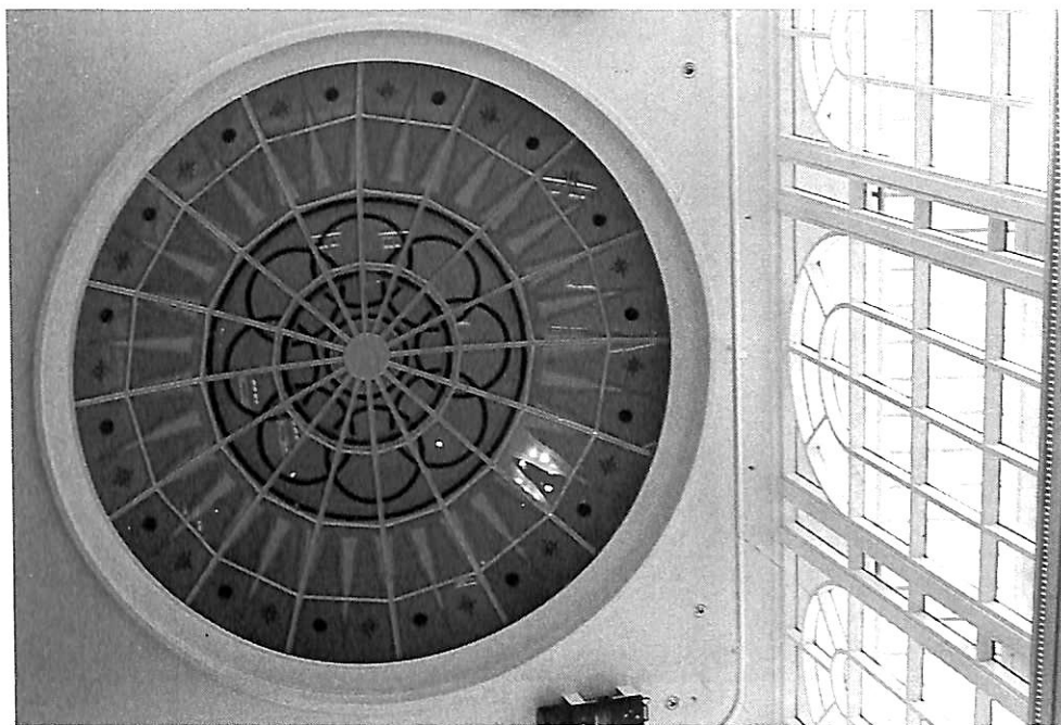
▲ "Grand Centrum" 7層吹き抜けの天井部、ネオンも無く、すっきりしていて気持ちが良い、デザインも大変良い。(赤色系の太陽と黄色系ライン)
