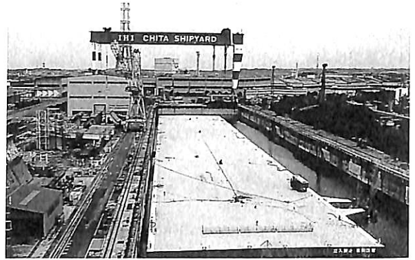
▲ 愛知工場で完成した浮体ユニットの一部
