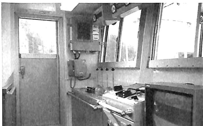
▲ 船尾コントロール室
