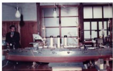
Mm C 0 pt 敷島 1973修理 17
