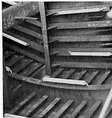
アルミ陽極取付 バラストタンク
