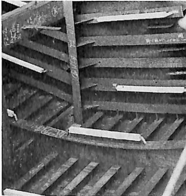
アルミ陽極取付 バラストタンク
