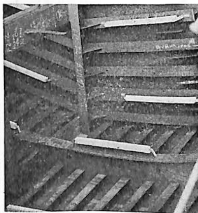
アルミ陽極取付 バラストタンク
