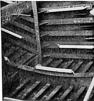
アルミ陽極取付 バラストタンク
