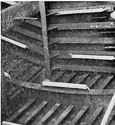
アルミ陽極取付 バラストタンク
