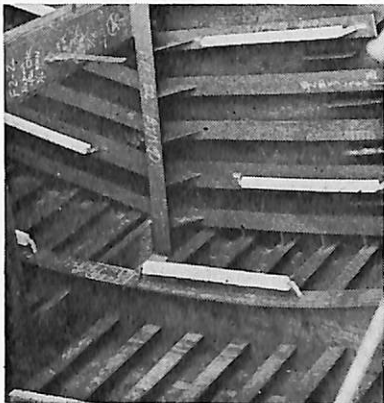
アルミ陽極取付 バラストタンク
