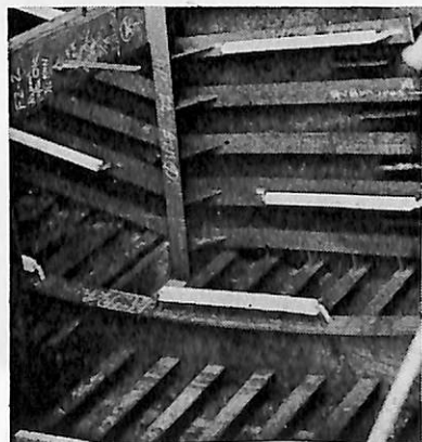
アルミ陽極取付 バラストタンク
