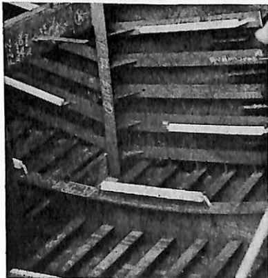
アルミ陽極取付 バラストタンク
