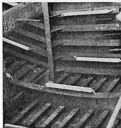
アルミ陽極取付 バラストタンク
