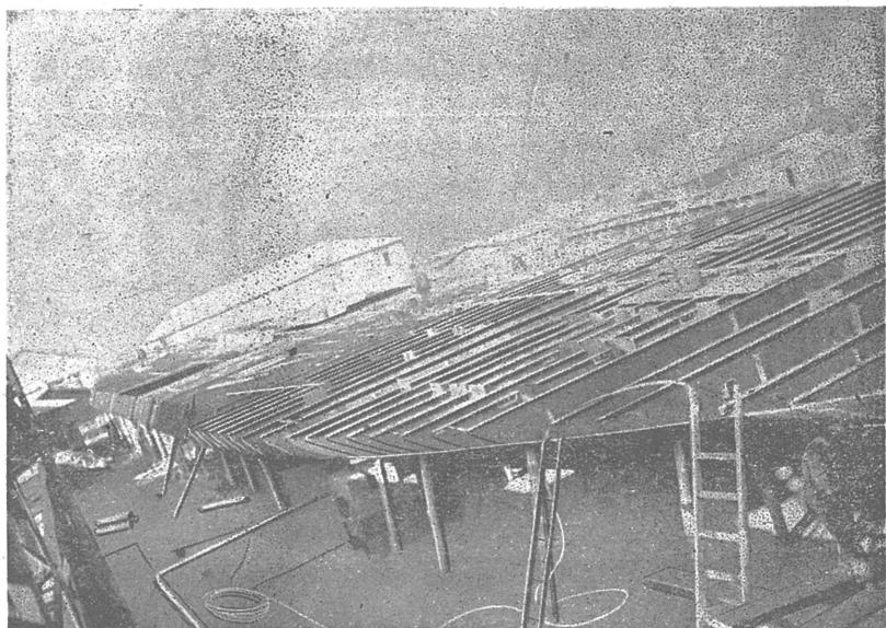
實體肋板で固めた船首船底部の二重底寫眞
