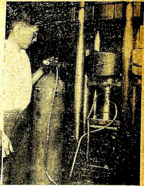
寫眞 F 圓筒を上下から機械で 押付け、水素をポンペ から供給している
