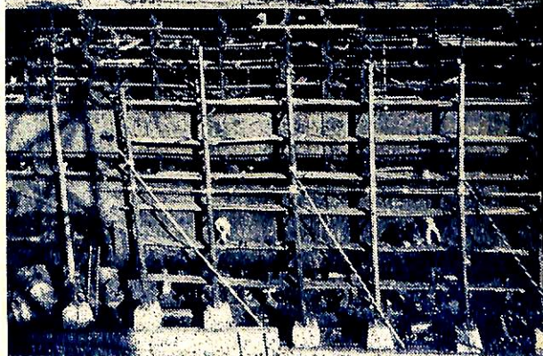
外板取付作業状況
