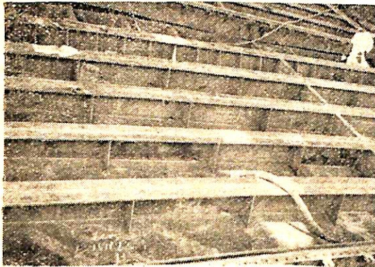
第11圖 鋼製艙口蓋内面溶接の状況
