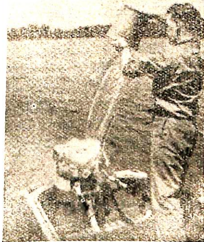
第2圖 シリコーン絶緣を行つた船舶用モーターは水をかけても故障なく回転している
