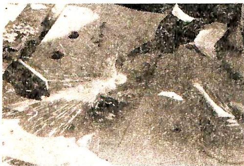
第34圖 ガウチングによる皿銜切斷
