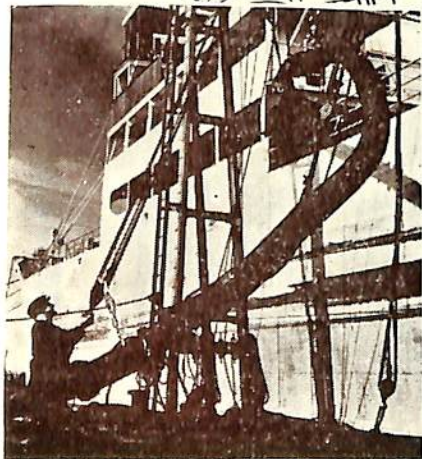
重油、原油陸揚中の'テリレン'製油 送ホース
