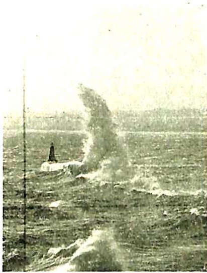
小名浜港（福島県）防波堤における波浪 （灯台の高さは 15 m）
