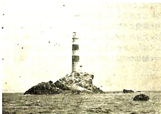
写真-2 水の子灯標 (大分県南海部郡豊後水道)
