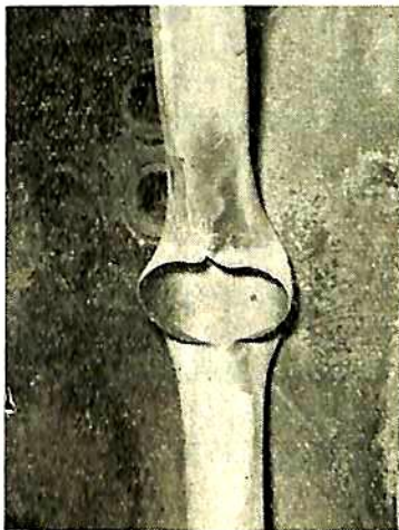
第24図 丸ボイラ水管の破裂開口の一例
