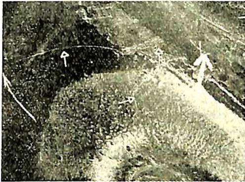
第23図 (A) 鏡板の膨出とそれに伴う亀裂の状況
