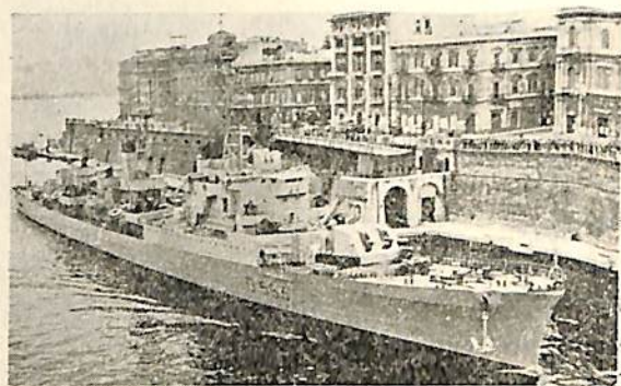
写真 14 イタリア大型フリゲート San Marco. 基準排水量約4,000トン(大戦中、未成だつた軽巡を最近設計を改めて完成)、速力36ノット。艦橋の前に見えるが Menon 式の三連装爆雷砲。英国のリンボーに相当する新兵器である。(A. Barill 氏提供)
