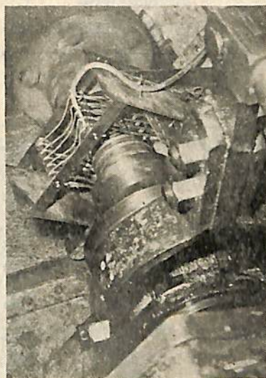
第2図 トーション・メーター(中間軸への装着状況)
