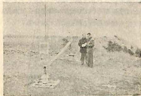
Fig. 45 アンテナ塔を倒す準備
