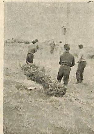
Fig. 46 徐々に倒れるアンテナ塔
